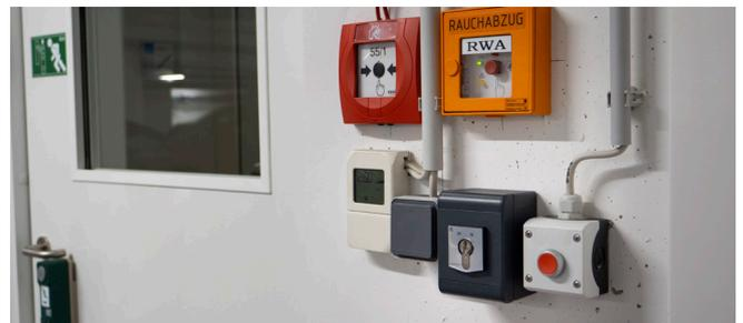
Das Aluminiumgehäuse für Schlüsselschalter kommt unter anderem im Zweckbau bei Eingangsportalen, Schranken, Aufzügen und Fahrtreppen zum Einsatz, aber auch in Einfamilienhäusern zur Steuerung von Garagentoren, Ladesäulen und Poolabdeckungen.
