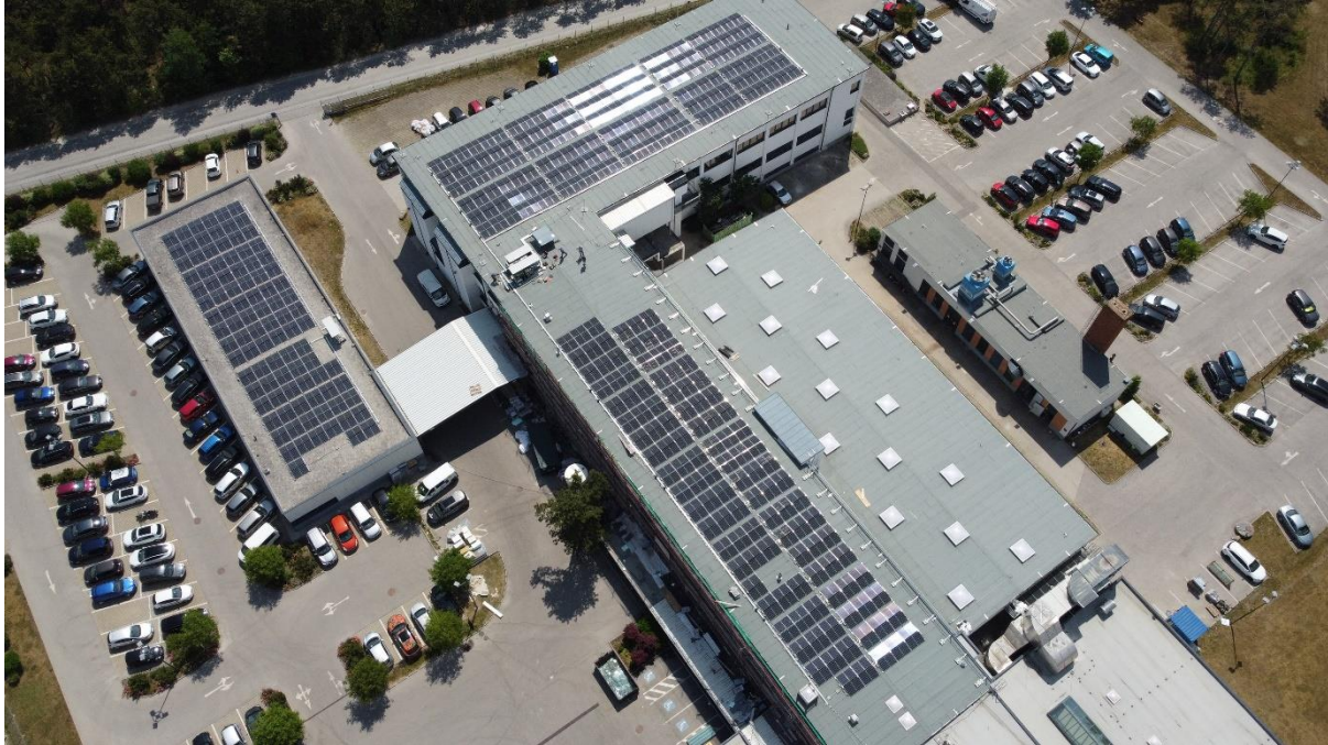
Photovoltaic system on the roof of Kraus & Naimer Produktion GmbH in Weikersdorf (Lower Austria)
